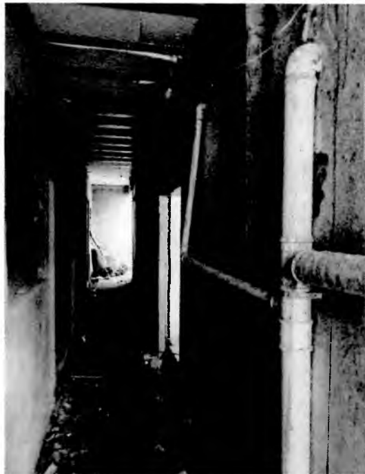
Foto 01: viga e pilares corredor primeiro pavimento.
