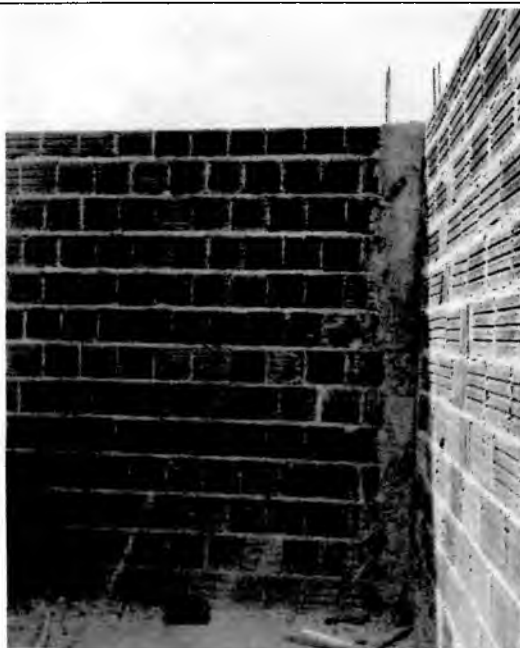
Foto 03: pilares 1º pavimento.
