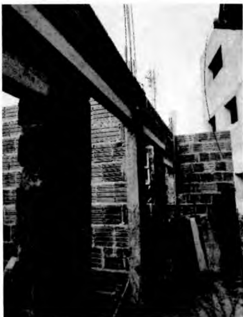
Foto 05: verga aplicada em vãos de portas e janelas.
