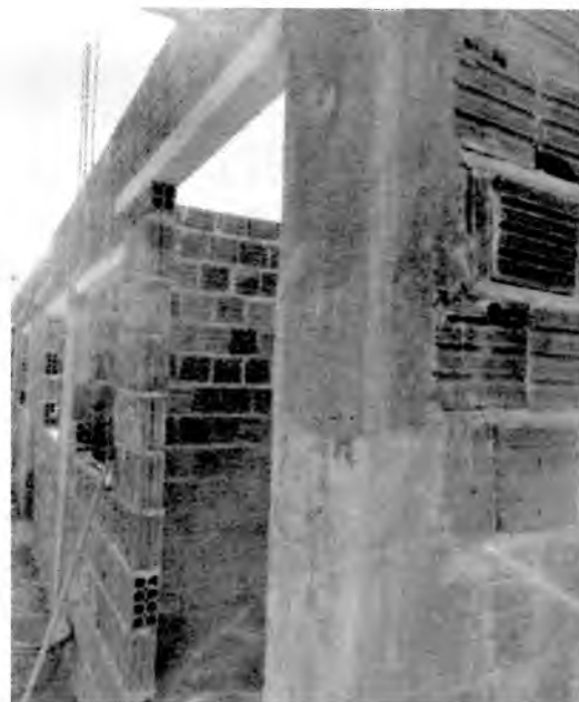
Foto 04: pilares 1º pavimento.
