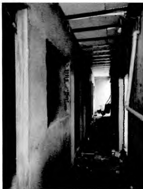
Foto 06: Laje primeiro pavimento.
