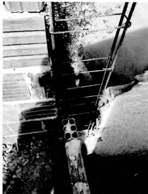
Foto 02: armação para concreto armado aplicado em pilares.
