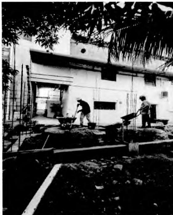
Foto 02: concretagem de viga baldra, alvenaria de embasamento de 1 vez, concretagem de pescoço de pilares
