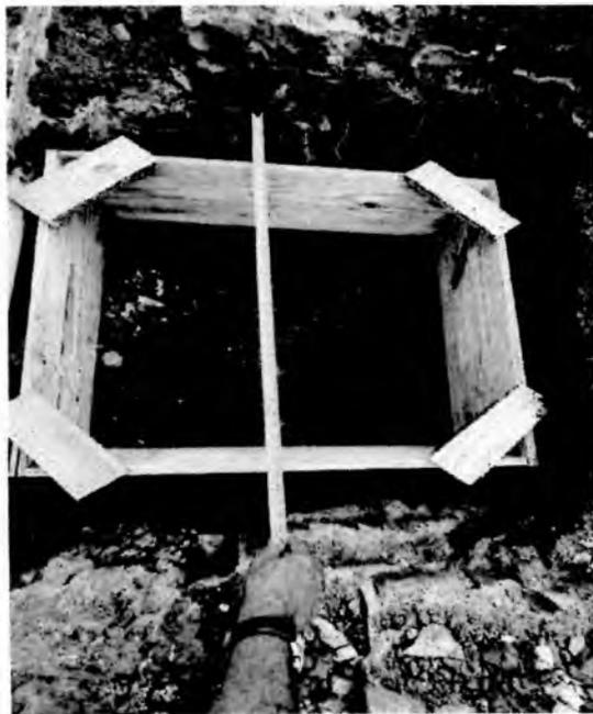
Foto 05: Caixaaria para concretagem de sapatas.
