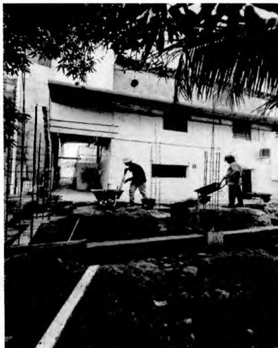
Foto 02: concretagem de viga baldra, alvenaria de embasamento de 1 vez, concretagem de pescoço de pilares
