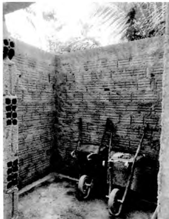
Foto 08: Lastro de concreto magro aplicado em ambientes internos as salas, chapisco aplicado em alvenarias.
