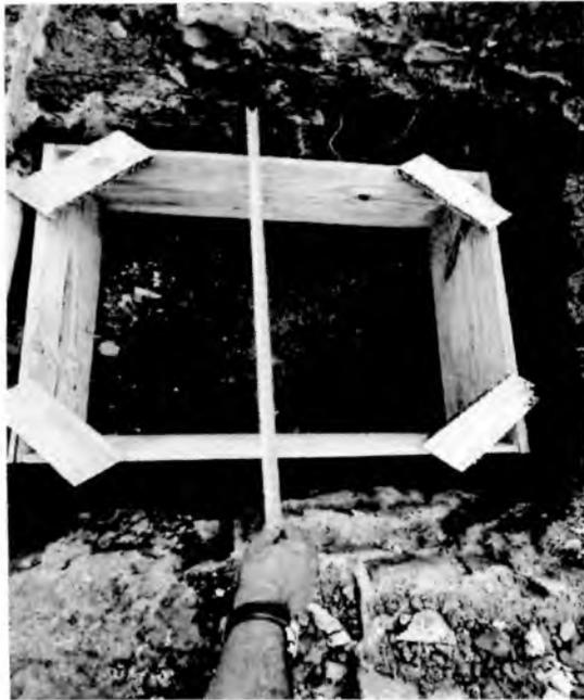
Foto 05: Caixaria para concretagem de sapatas.
