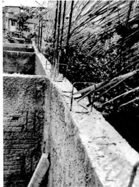
Foto 06: Vigas superiores concretadas.
