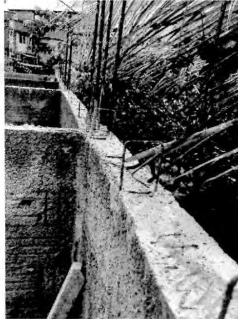
Foto 06: Vigas superiores concretadas.
